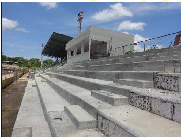
Construcción de la Sala de Certificación y revestimiento de graderías.
