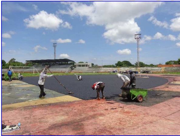
Vista panorámica de la Pista de Atletismo, donde se aprecia la instalación de base para colocación de piso poliuretánico de 14 mm de espesor en sector este y sector "D"
