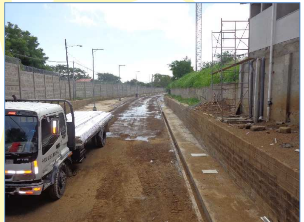
Panoramica de la conformación final de la pista de atletismo.
