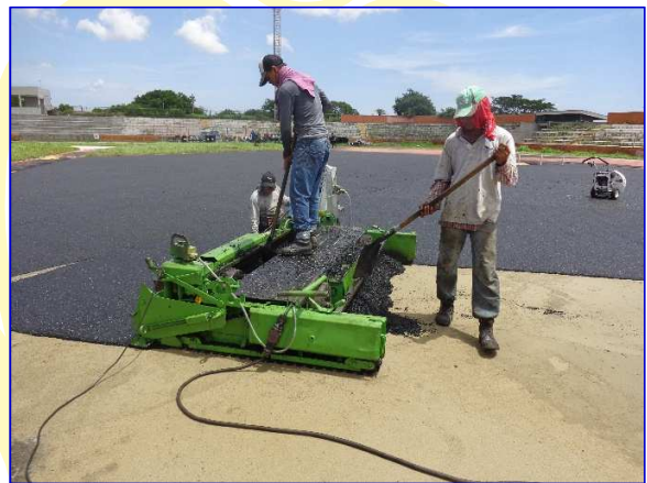
Vista panorámica de la Pista de Atletismo, donde se aprecia la instalación de base para colocación de piso poliuretánico de 14 mm de espesor en sector este y sector "D"
