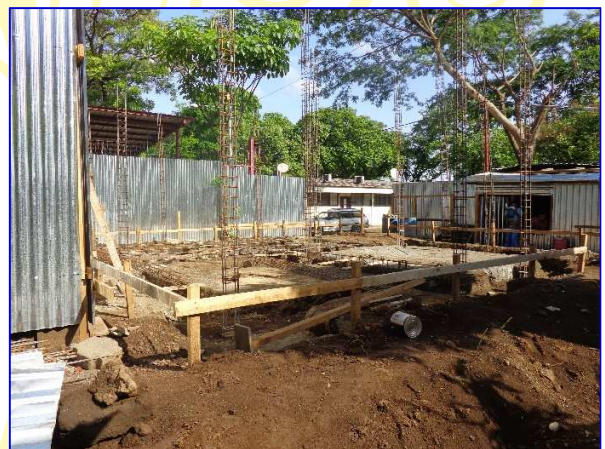
Costado Norte del área donde se está construyendo el Puesto de Seguridad. Apreciar le ejecución de las actividades de demoliciones, movimiento de tierra, excavación de fundaciones y colocación de acero de refuerzo.
